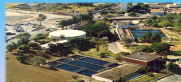
ETA 1 (1936) / ETA 2 (1961) – Vazão Média de Operação: 637L/s
