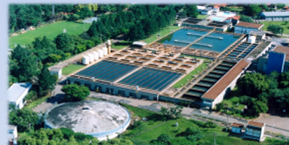
ETA 3 (1972) / ETA 4 (1991) – Vazão Média de Operação: 2.550L/s
