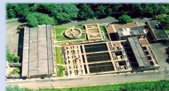
ETA Capivari (1983) – Vazão Média de Operação: 220L/s
